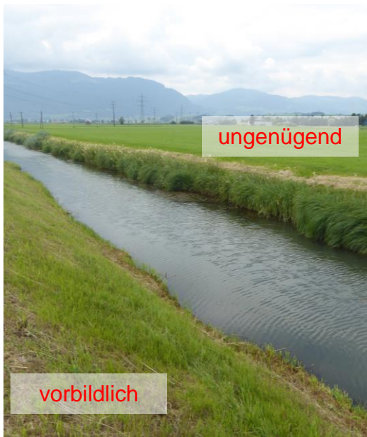
Unbefestigte Böschung: Böschung ist bis zum Wasserspiegel zu mähen und das Heu abzuführen.
